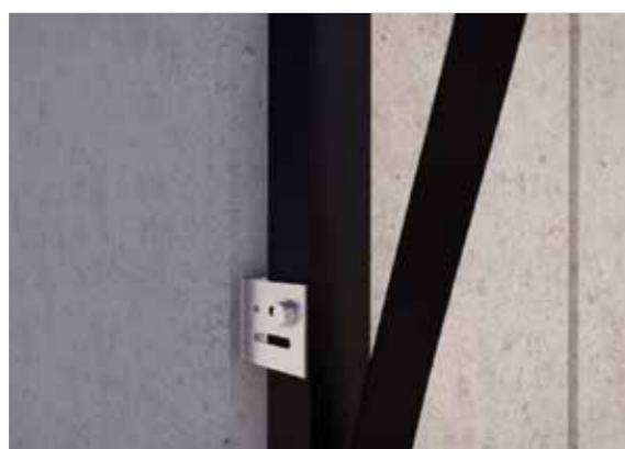
3 _ Applicazione di bandella dielettrica / Application of dielectric band
